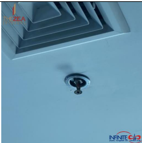
หัวกระจายน้ำดับเพลิง Sprinkler
