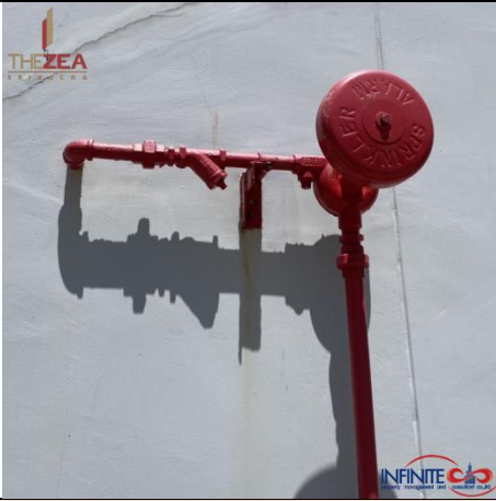
กริ่งสัญญาณเตือนเพลิงไหม้
